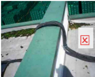
Obrázok 13 – Príklad vhodného a nevhodného vedenia káblov cez požiaru stenu na streche
