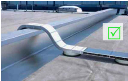
Obrázok 13 – Príklad vhodného a nevhodného vedenia káblov cez požiaru stenu na streche
